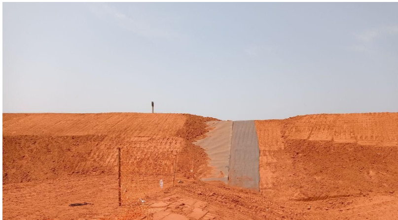
Figura 21 - As duas camadas de mantas impermeabilizantes.
